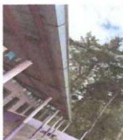
Foto 11: CANALES Y BAJADAS DE AGUA PLUVIAL Sustrucción de canales para evacuación de aguas pluviales Material: lámina galvanizada Tipo: lisa Anclaje: canal sostenido por pescantes metálicos.
