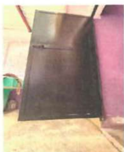
Foto 9: PUERTAS Mantenimiento a puertas metálicas existentes, retiro de óxido, suciedad y pintura deteriorada; incluye: cepillado, lijado y aplicación de pintura
