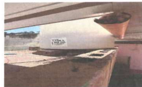
Foto 6: REPARACIÓN Y MANTENIMIENTO DE CISTERNA DEPÓSITO DE AGUA. Sustitución de cisterna y accesorios de tanque de almacenamiento de agua.
