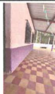
Foto 8: REPARACIÓN DE REPELLO Y CERNIDO DE PAREDES Reparación de repello y cernido en muros de mampostería con aplicación de acabado uniforme.
