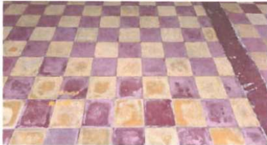
Foto 1: PISO Sustitución de piso de granito por piso de granito, incluyendo preparación de superficie y nivelación
