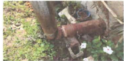
Foto 4: REPARACIÓN O SUSTITUCIÓN DE ÁREA DE COCINA sustitución de chimenea de estufa rural
