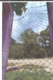
Foto 5: CERCO O MURO PERIMETRAL Sustitución malla de acero galvanizado en perímetro del establecimiento, con instalación fija y tensa, anclajes metálicos en intervalos regulares
