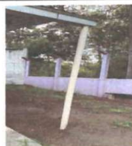
Foto 12: CANALES Y BAJADAS DE AGUA PLUVIAL Sustrucción de bajantes para evacuación de aguas pluviales ancladas por medio de abrazaderas y tornillos
