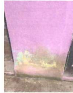
Foto 2: PINTURA EN MUROS INTERIOR Y EXTERIOR Preparación de la superficie y aplicación de pintura a dos manos, en paredes interiores y exteriores del establecimiento.
